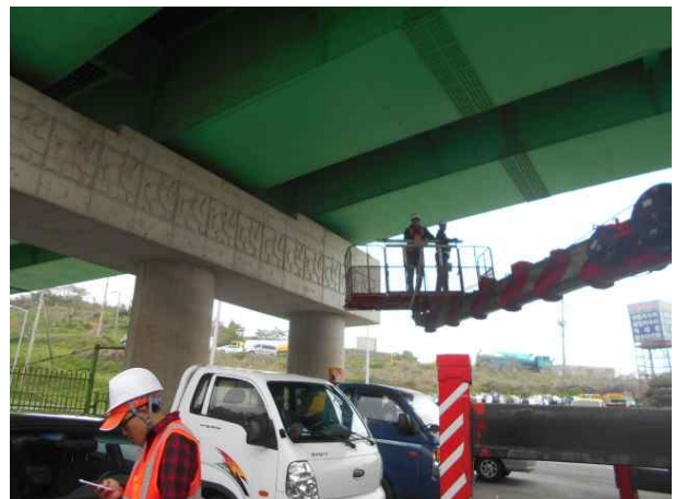
고소차량을 이용한 외관조사
